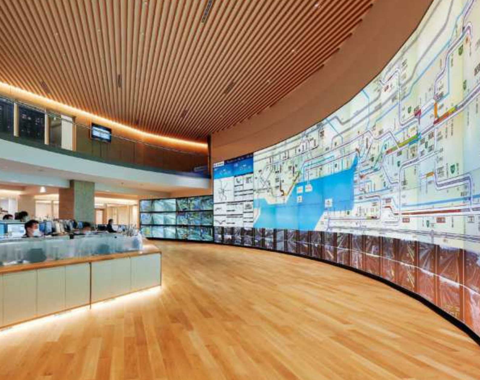
朝潮橋管制室 Asashiobashi Control Room
