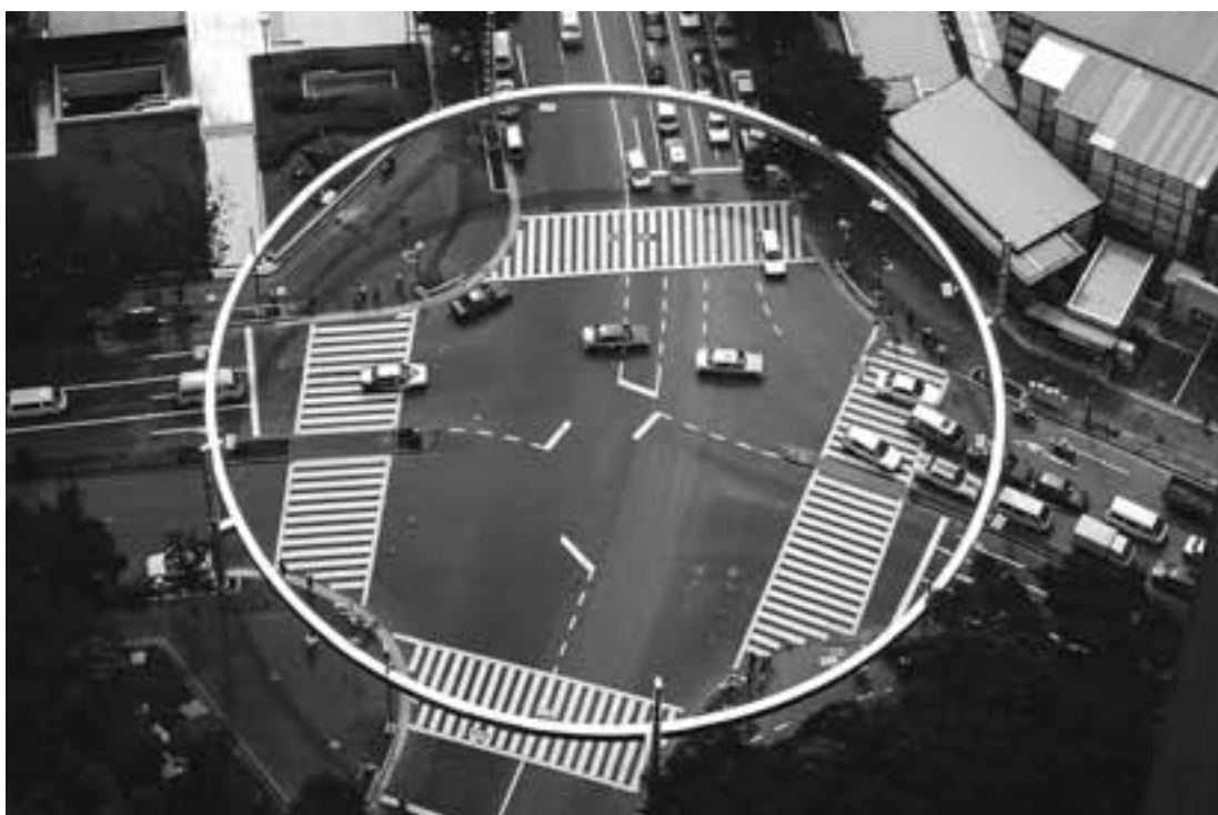
ストリートファニチュアの統合により空間をランドマーク化した西新宿サインリング 直径 54m 高さ 15m 1994年
