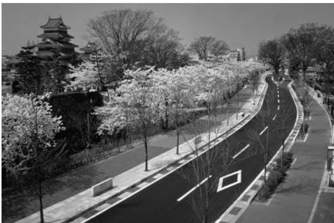
松本城をひきたて、日本的な「地」の道路空間をつくる 宮渕新橋上金井線改良事業 1992年
