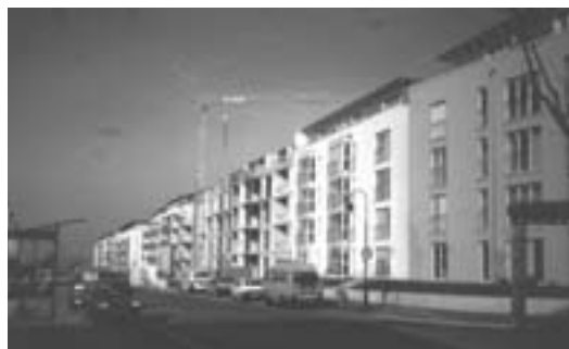
建設中のリーゼルフェルト新住宅団地
