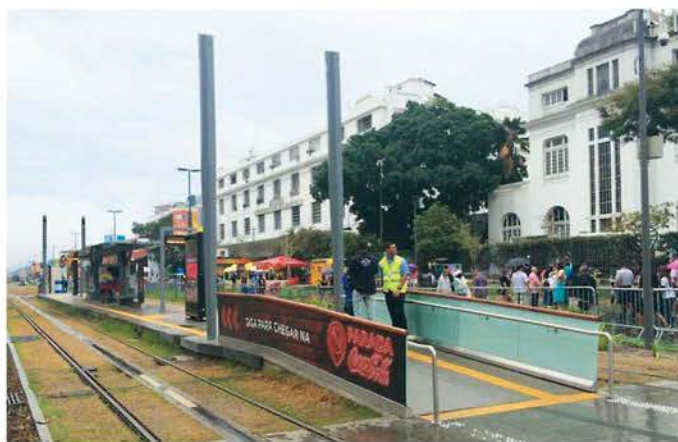
ヒューマンスケールに配慮されたLRT停留所のデザイン。 LRT stations considering human scale designs.
