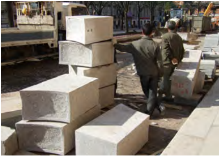
道路改修工事現場に積み上げられた舗装材。断面40cm角の縁石。
