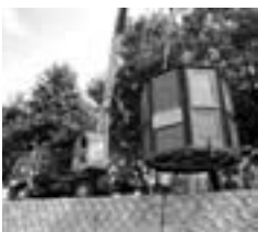
搬送してレッカーで吊り降ろす
