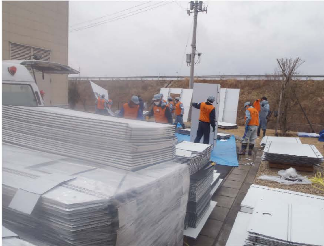
折板構造なので折り紙の様に組み立てる
