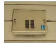
地下鉄入口部天井に設置されたスピーカー。「ピン・ポーン」またはこれに類似した音を鳴らす。
