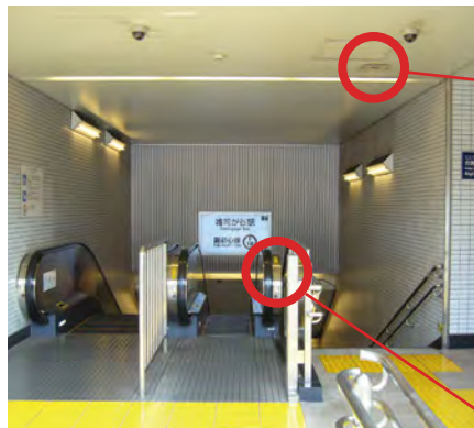
地下鉄入口部天井に設置されたスピーカー。「ピン・ポーン」またはこれに類似した音を鳴らす。
