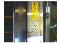
エスカレーター昇降口に内蔵されたスピーカー。「(行き先)(上下方向)エスカレータです」の音声が行れる。
