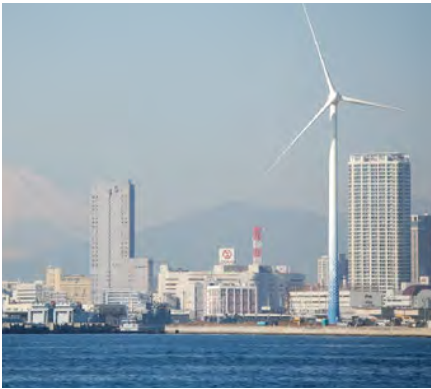
風力発電施設タワーグラフィック／横浜市環境創造局 2007：ドットグラデーションを施し、みなとみらい地区からの眺望を考慮した風力発電。都市景観との調和により自然エネルギーの利用促進を図る。
