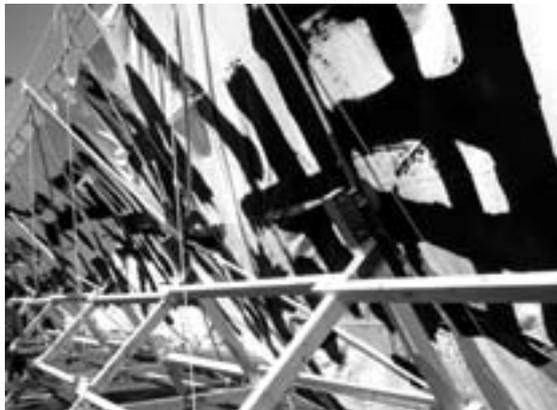
竹材と縄のテンション構造による大幡（書幡）のストラクチャー。
